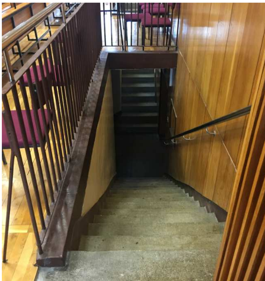
Zdj. 5 Okładzina posadzek – parkiet drewniany (pomieszczenie auli), zejścia (Iastriko)
